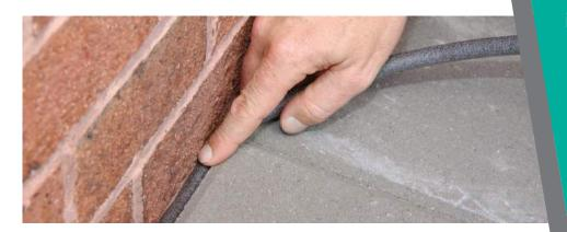
Tira cilíndrica de espuma de polietileno impermeable y elástica que se coloca en el interior de juntas de expansión y en grietas como materiales de respaldo.
